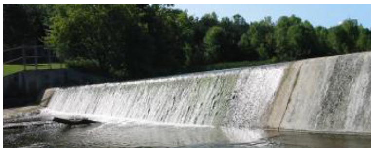
Inspection du barrage, municipalité de Russell
