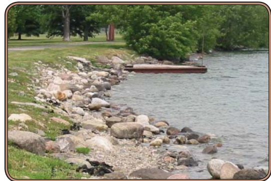
Le rivage de Morrisburg avant les travaux de réfection.
