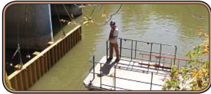
Installation d'un batardeau.
