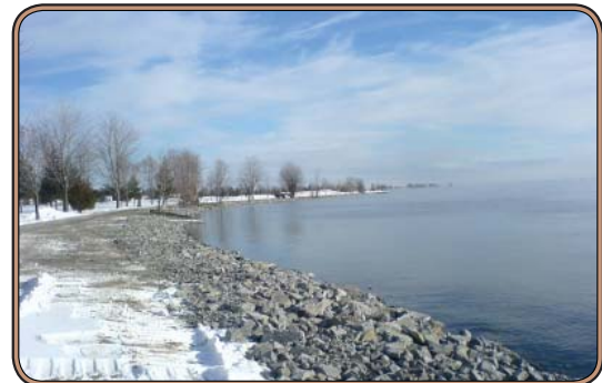
Le rivage de Morrisburg après les travaux de réfection.
