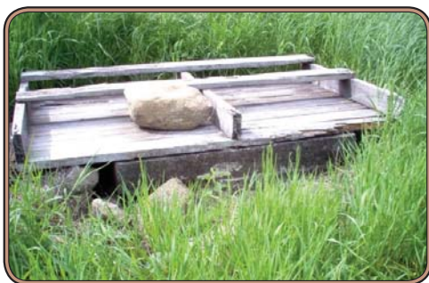
Un puits-creusé avant les travaux de désaffectation.
