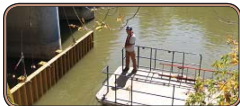
Installation d'un batardeau.
