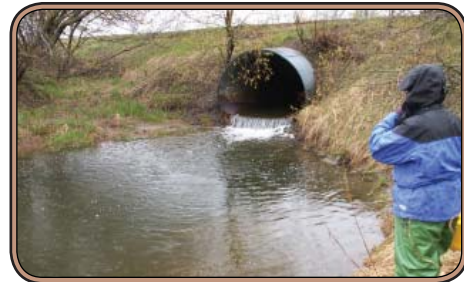
Le rigolet Stark avant l'application des mesures correctives.
